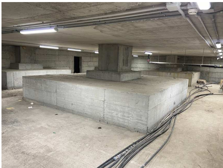
Figura 2: Particolare plinti fondazione
