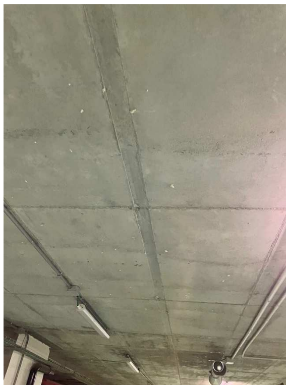
Figura 4: Particolare solaio gettato in opera
