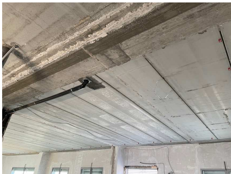
Figura 5: Solaio in "predalles"
